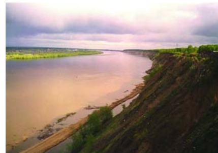
Рис. 1. Естественный береговой склон на будущей площадке строительства
