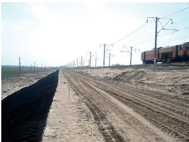
Рис. 5. Укрепление откоса бермы земляного полотна на Приволжской дороге
