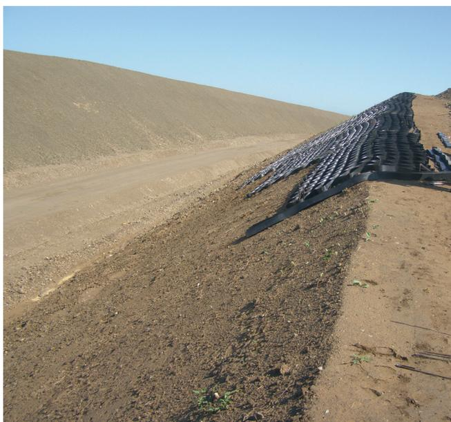
Рис. 1. Объемные пластиковые геоячейки «Прудон-494» для укрепления откосов выемки
