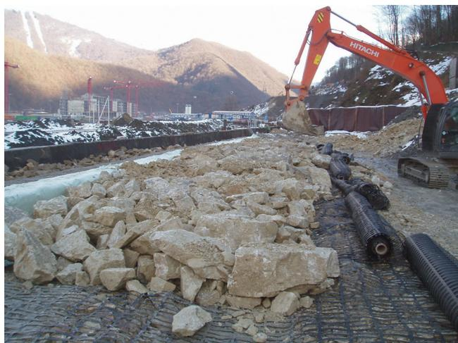
Рис. 3. Строительные операции на армогрунтовой насыпи
