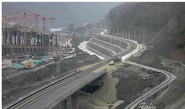
Рис. 4. Армогрунтовая насыпь на ПК457+00 — ПК467+71
