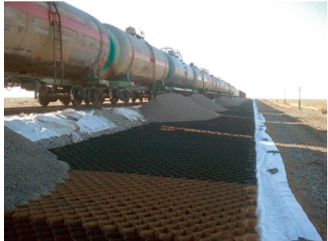
Рис. 6. Применение геоячеек «Прудон-494» для усиления основной площадки земляного полотна
