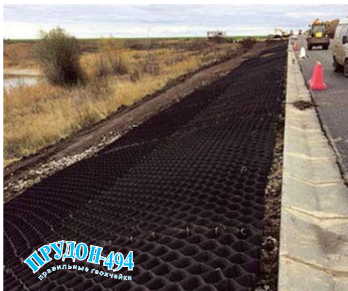
Откосы автодороги М-4 «Дон»
